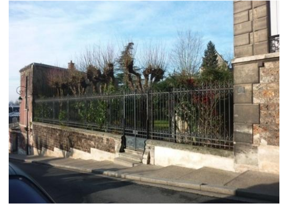
Mur bahut surmonté d'une grille ajourée
