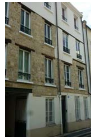
Traitement mixte d'une façade avec maintien et suppression des enduits
