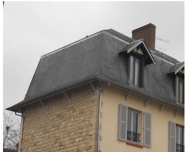
Détail avec lucarnes en brisis et souche de cheminée en terrasson
