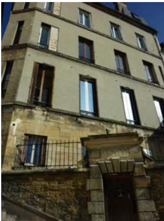
Mur de clôture conservé dans son état d'origine place de la Harengerie.
