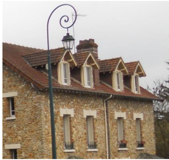
Couverture et lucarnes en tuiles mécaniques
