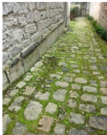
Pavé + joints de terre et chaux:
