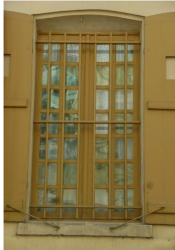
Fenêtre à petits carreaux du XVIIIème s - Carmel de Pontoise
