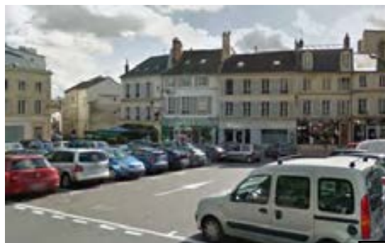
Un aspect « parking » dommageable
