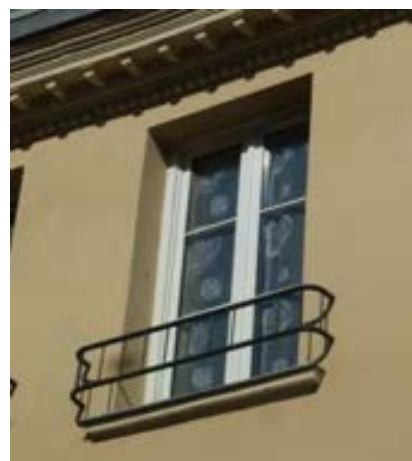
Garde-corps tubulaire en fer ayant remplacé un garde-corps plus ancien
