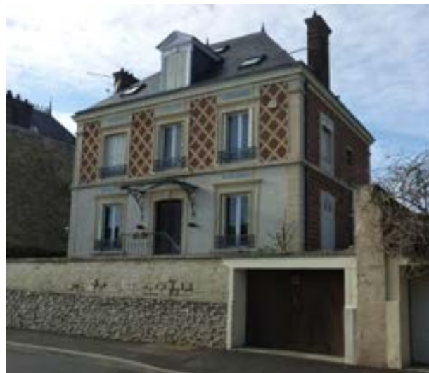
Maison de maître en brique et pierre rue Victor Hugo
