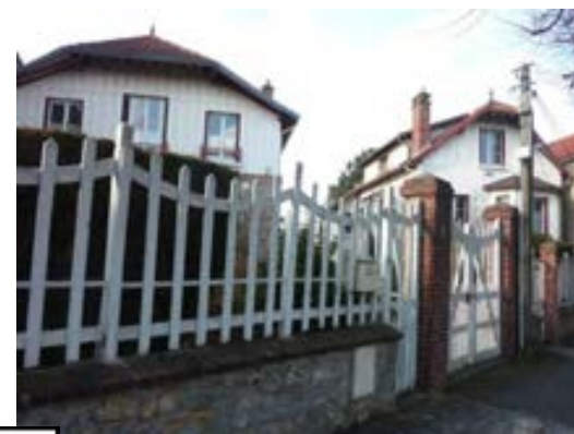
Clôtures en bois sur le boulevard Jacques Tête
