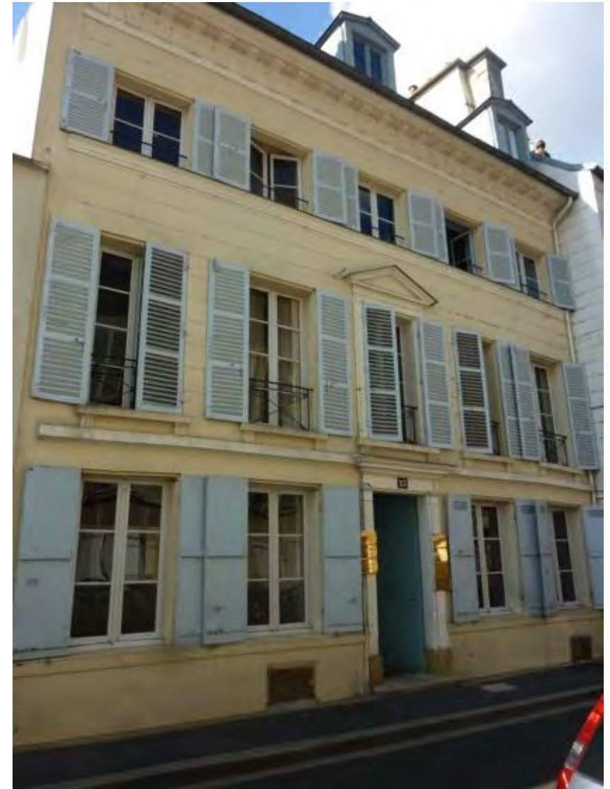
Maisons et petits immeubles à décors de plâtre rue Pierre Butin
