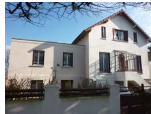
Création d'un nouveau volume en extension de la construction années 30. Le nouveau volume tranche avec l'architecture préexistante mais le traitement de la façade en est proche. L'impact visuel de l'extension est néanmoins prégnant du fait d'un volume important.
