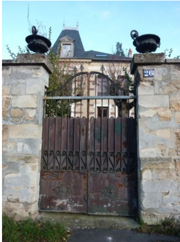
Mur plein en maçonnerie
