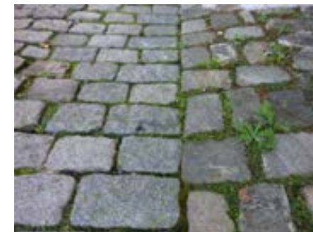
Exemple de revers pavés semi perméables aux abords des murs écartant les eaux de rejaillissement
