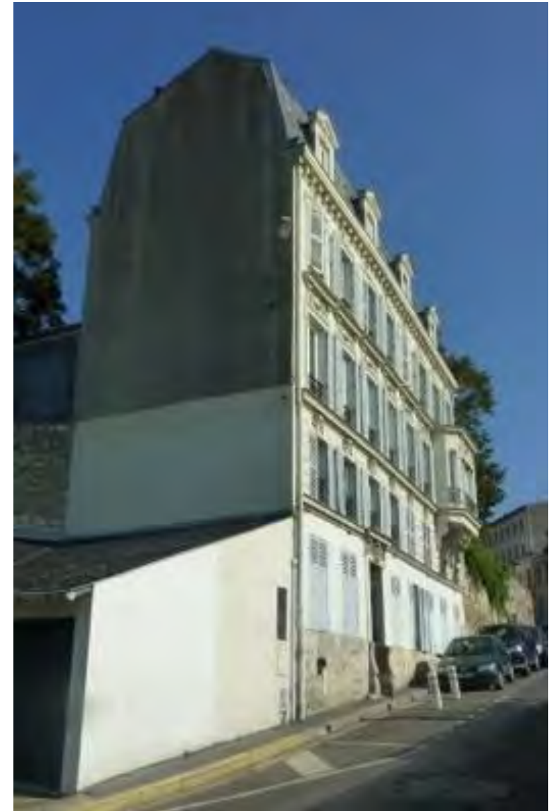
Immeuble de rapport rue de la Coutellerie
