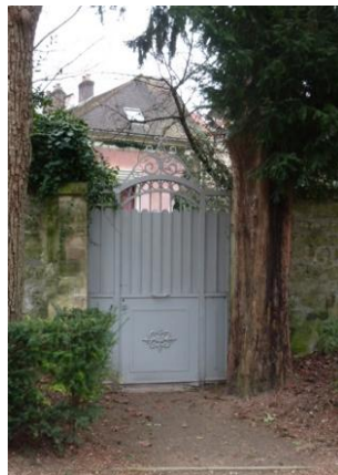
La hauteur de la porte coïncide avec celle du mur assurant une continuité visuelle de la clôture
