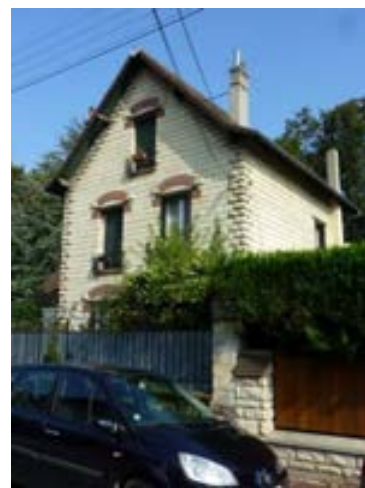
Rue du Mal Canrobert
