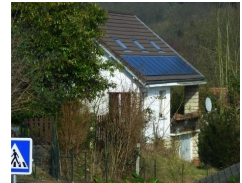
Installation solaire Boulevard Jacques Tête
