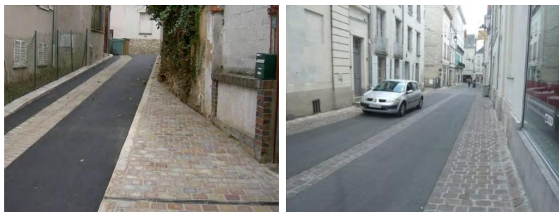
Privilégier des trottoirs clairement identifiables mais au niveau de la voie sur les rues étroites afin de faciliter l'accessibilité
