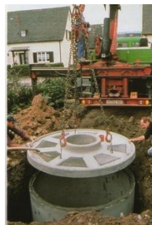
Installation d'une citerne enterrée
