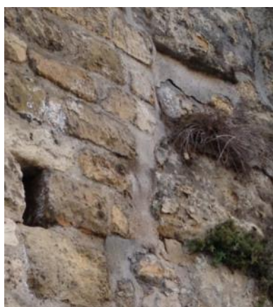
Dégarnissage des joints et mise en œuvre d'un rejointoiement au ciment
