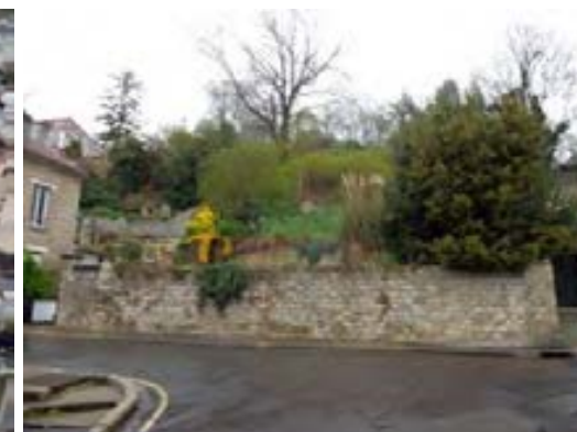
Les murs de soutènement des parcelles jardinées
