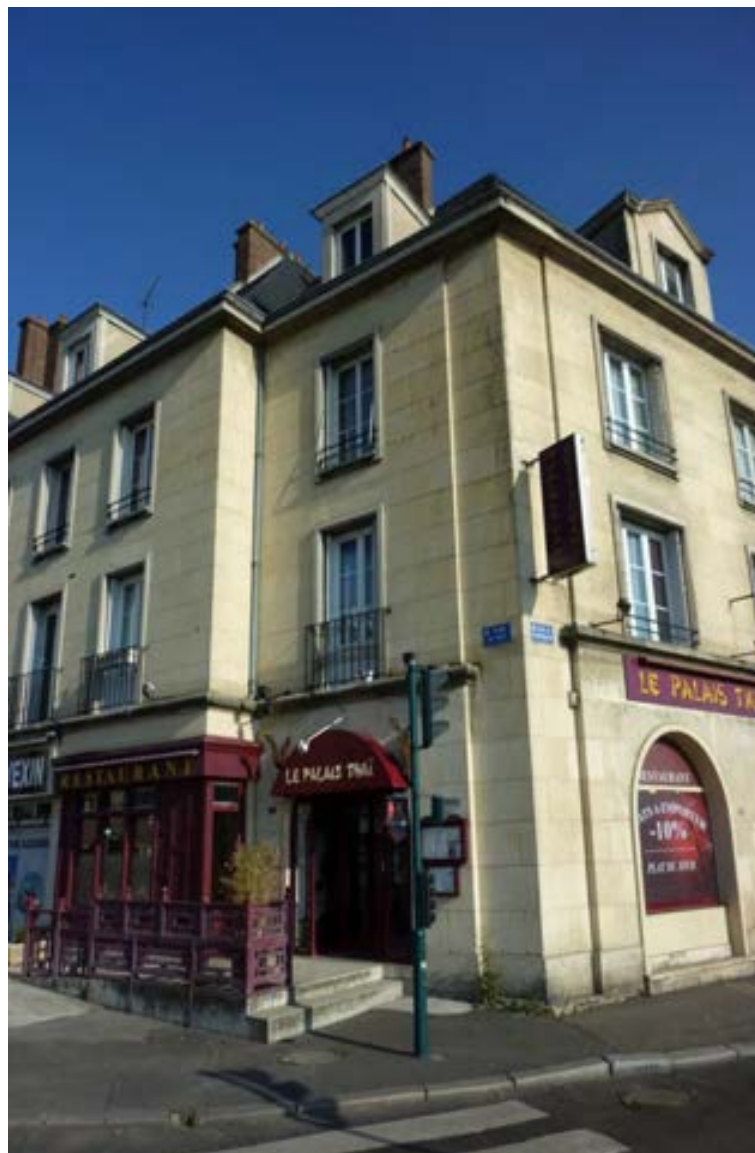
Les caractéristiques principales sont: une architecture sobre, réalisée à partir de maçonneries en pierre calcaire, de baies adaptées aux types de pièce, d'un comble à 2 pentes avec lucarnes à croupe ou à fronton quai du Pothuis
