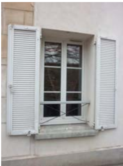
Fenêtre en PVC à faux petits bois intégrés dans le double vitrage, volets battants également en PVC
