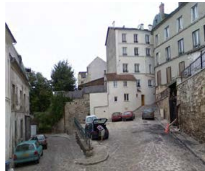
Etat actuel de la place de la Harengerie, structure globalement préservée malgré les modifications du bâti
