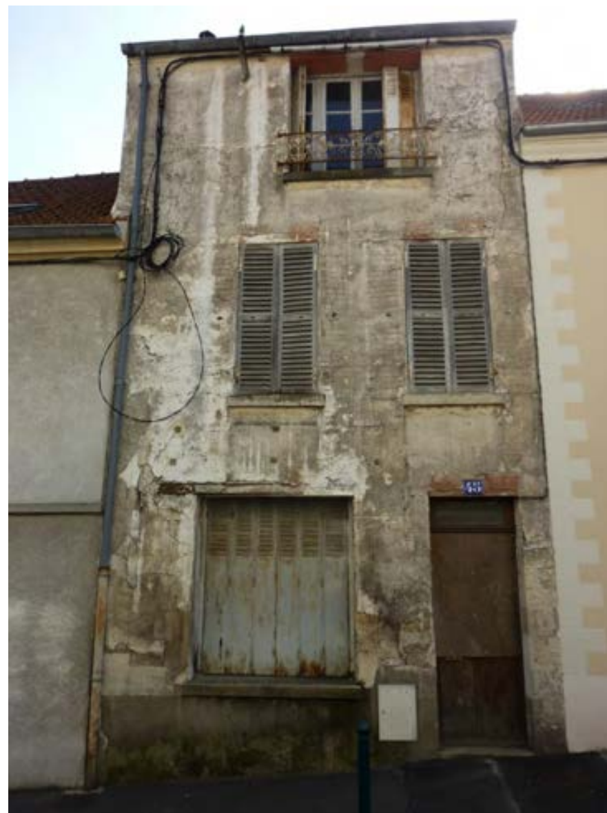
Modification de plusieurs baies - rue des Carrières
