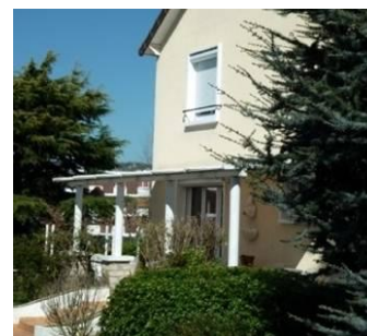
Extension et auvent avec toiture à faible pente invisible depuis l'espace public
