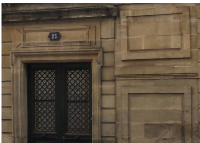
Détail d'un parement de façade
