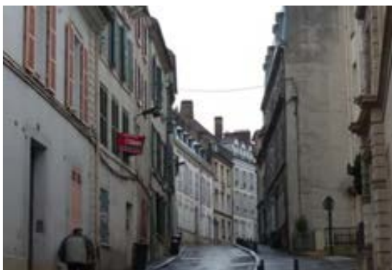
Maisons et petits immeubles à décors de plâtre rue de la Coutellerie
