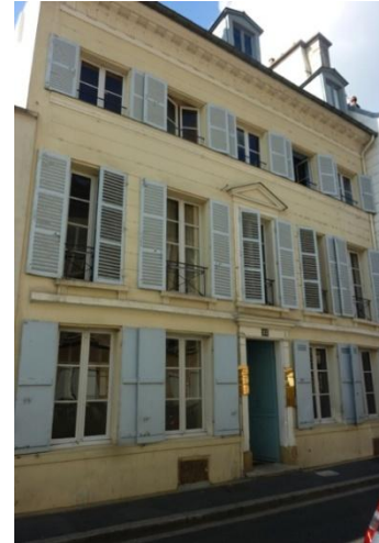
Volets bois totalement persiennés à l'étage et pleins au RDC - rue Pierre Butin
