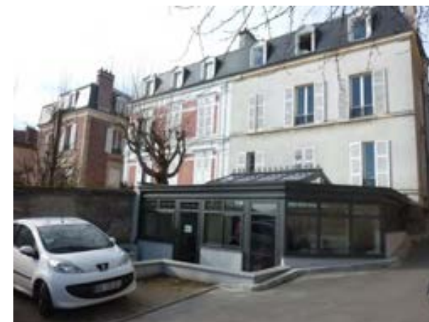
Création à RDC d'une petite extension en métal et verre. Cette extension présente un faible impact visuel et ne modifie pas la lecture de la façade principale - impasse Chabanne
