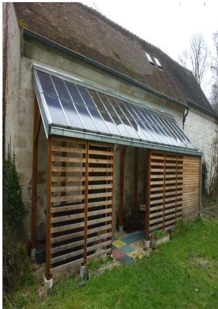
Exemple d'appentis intégrant des panneaux thermiques et PV - CAUE - Pontoise
