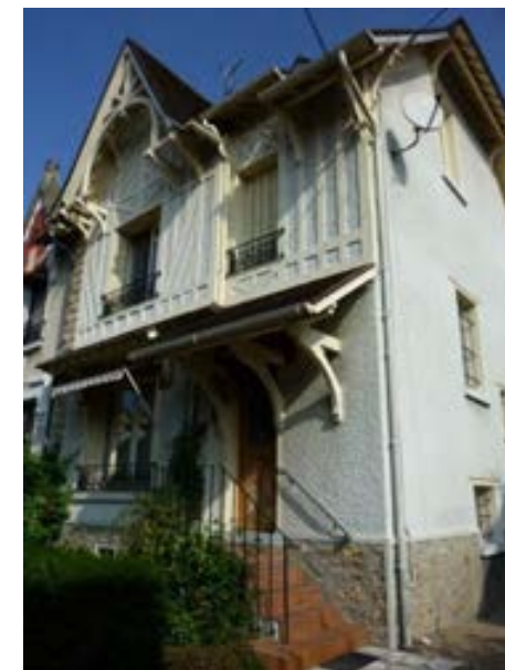
Villa en crépi et à motifs de faux pan de bois enduit - Avenue du Mal Canrobert
