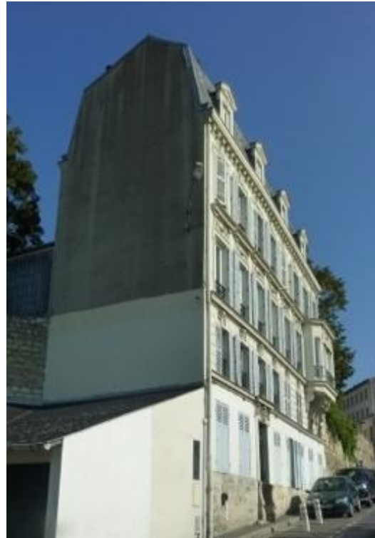
Immeuble de rapport rue de la Coutellerie
