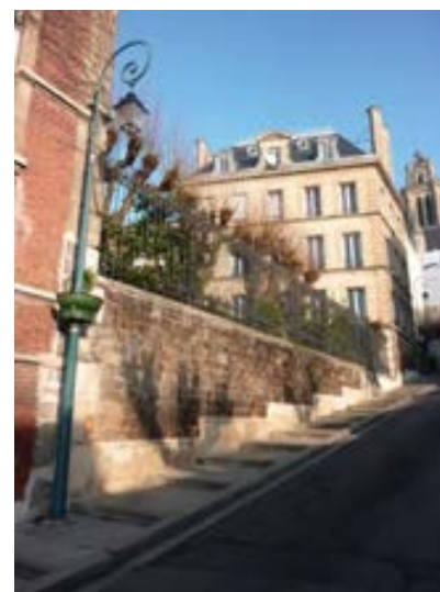
Mur bahut surmonté d'une grille ajourée
