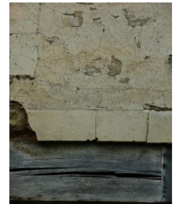
Détail sur enduit et linteau en bois
