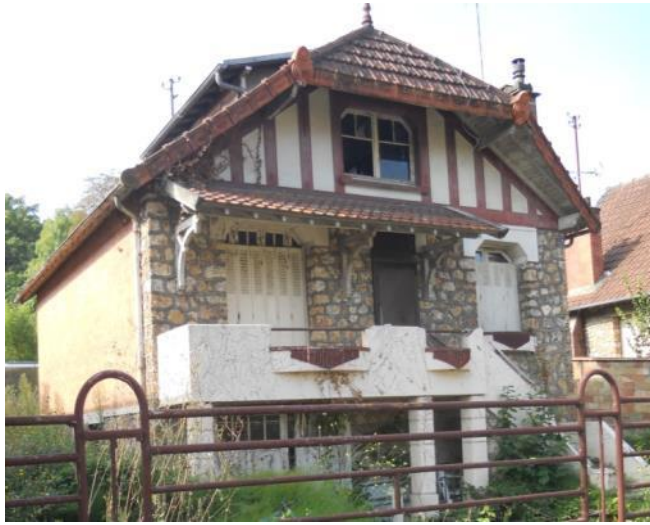
Couverture en tuiles mécaniques avec rives ouvragées
