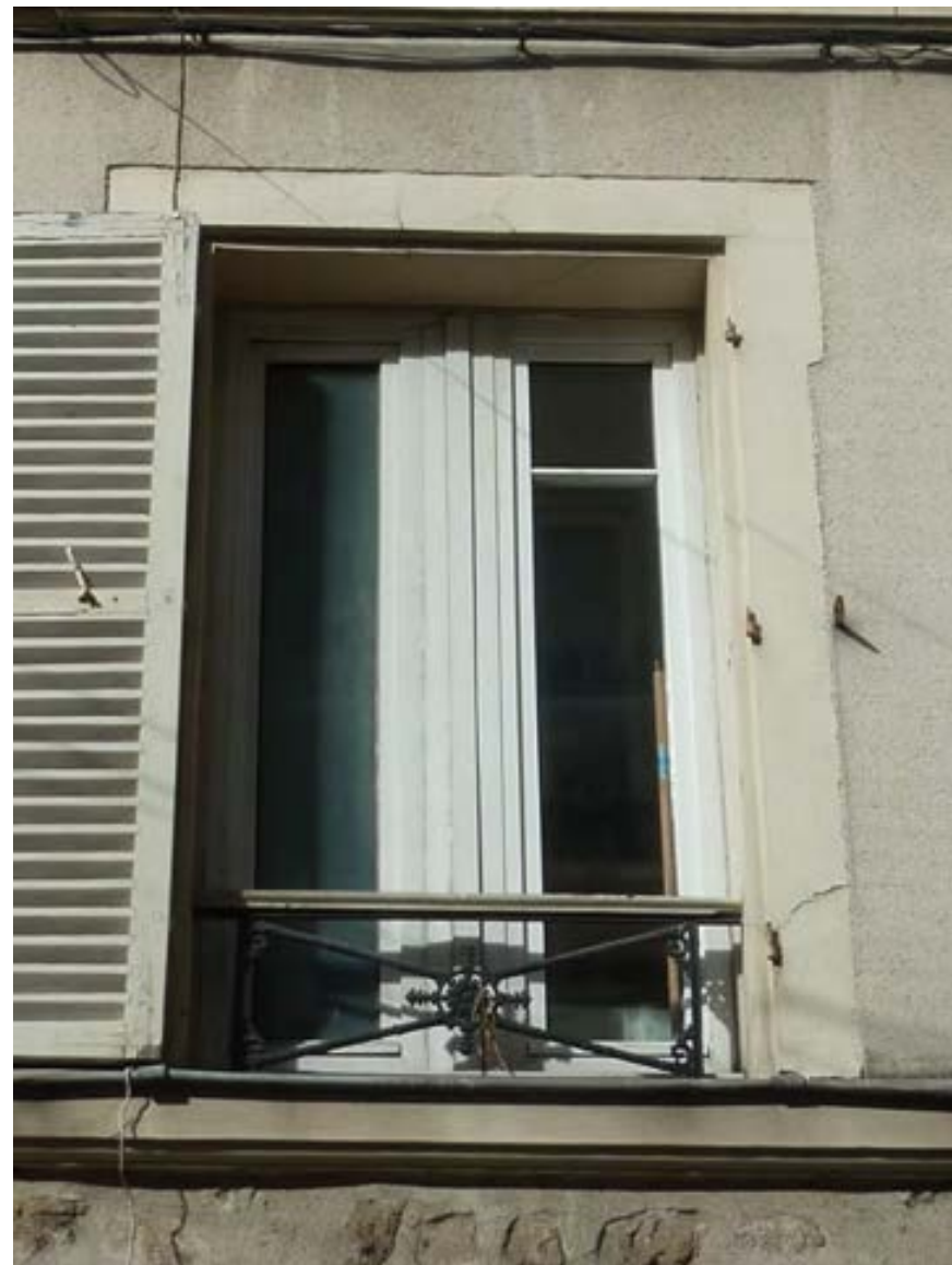
Le PVC présente des qualités mécaniques moindres que le bois. Cette faiblesse a nécessité une augmentation de l'épaisseur des profilés réduisant ainsi considérablement la surface des vitrages (clair de jour).
