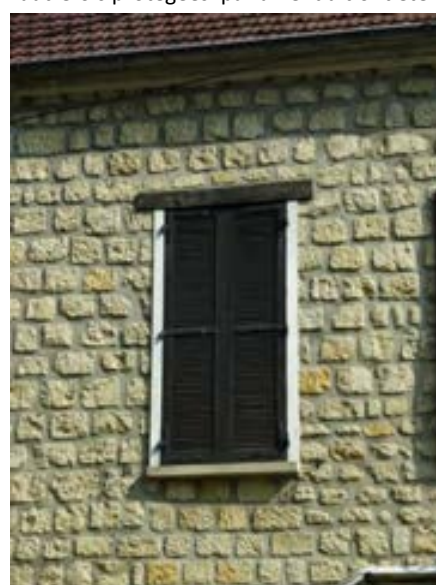
Maçonneries mises à nu et pose de faux linteaux en bois
