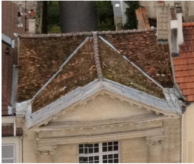
Exemple de tuile plate restaurée avec emploi de profil de noues et gouttière en zinc
