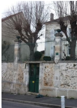
Mur en maçonnerie de moellons surmonté d'une grille ajourée. Rue Pierre Lavoye
