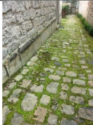
Pavé + joints de terre et chaux
