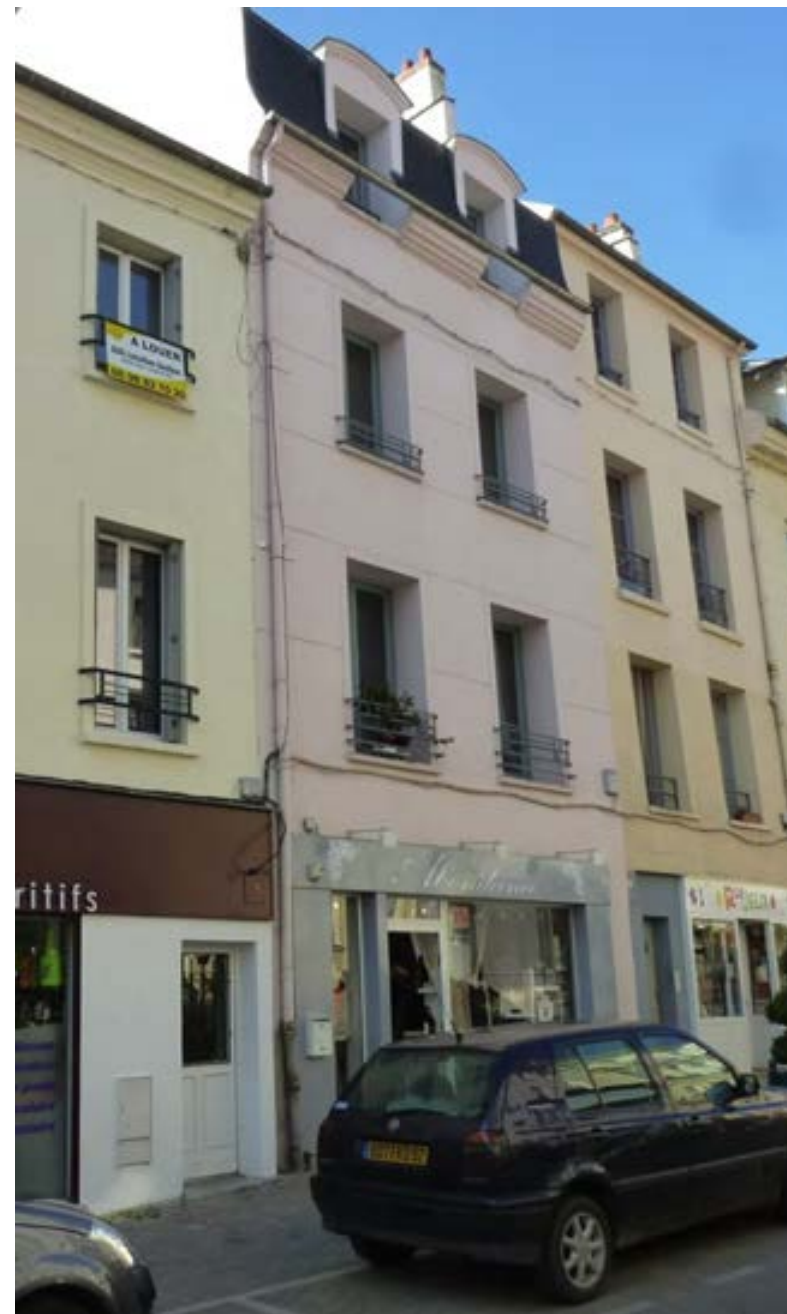
Façades ayant perdu leurs garde-corps d'origine - rue de l'Hôtel de Ville
