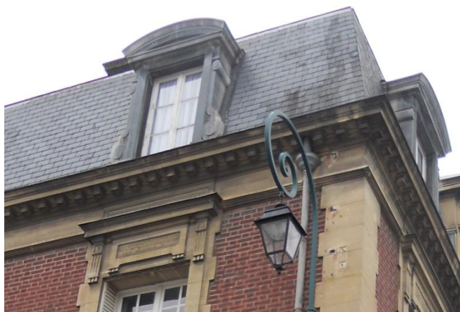
Détail de brisis en ardoise et habillage des lucarnes en zinc
