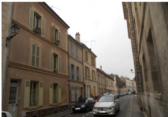
Front bâti sur rue Pierre Butin
