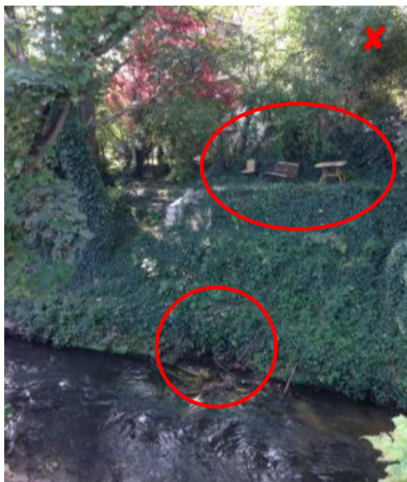
Désordre structurel au niveau du pied de berge risquant d'entraîner un glissement du talus / occupation sauvage du haut de berge par du mobilier.
