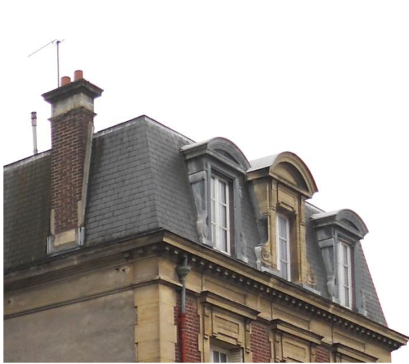
Détails avec lucarnes et souche de cheminée sur brisis
