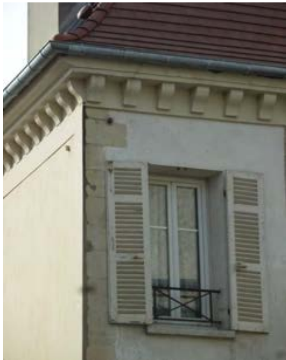
Bâti traditionnel à maçonnerie lourde - rue Lemercier
