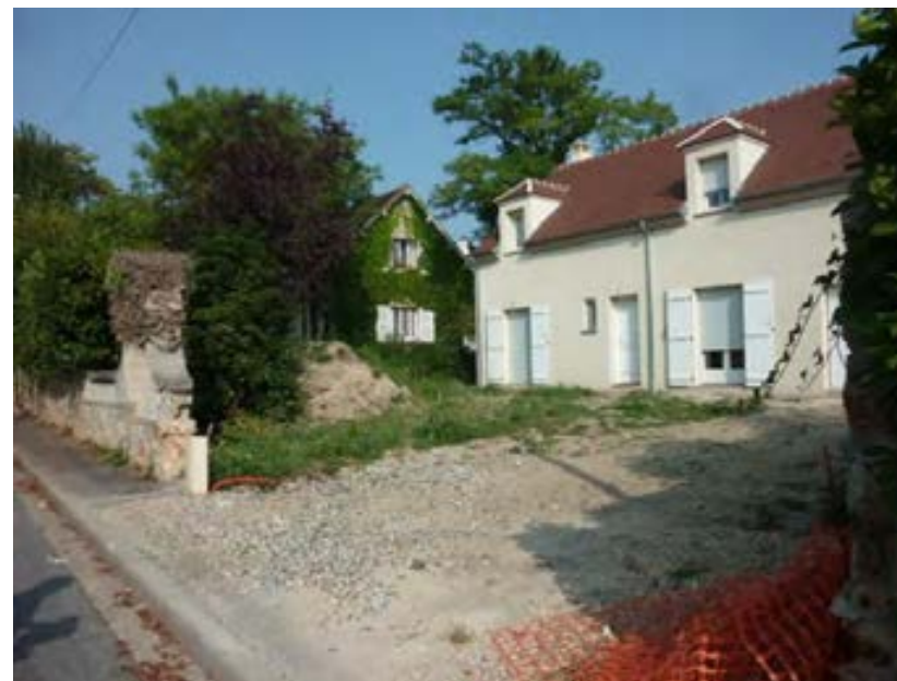
Démolition d'un mur maçonné pour faciliter la construction d'un pavillon
