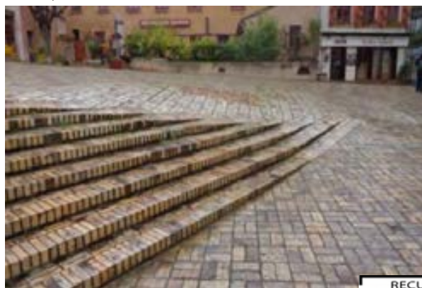
Omniprésence de la brique dans l'aménagement
