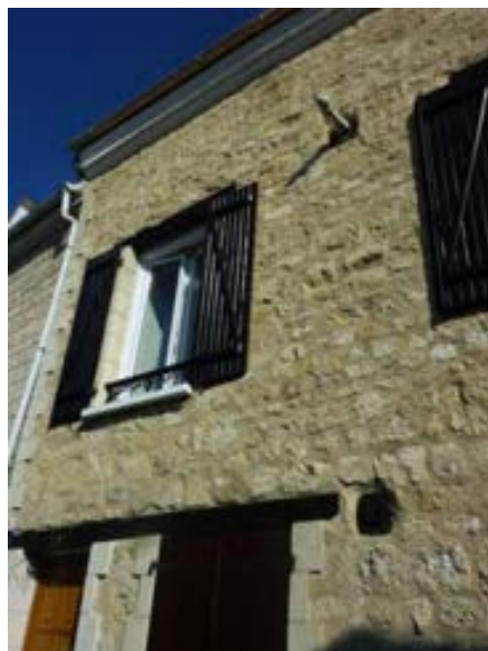
Maçonneries mises à nu et fortement dégradées (piochage des enduits, gel, pluies, etc...)
