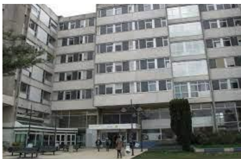
Bâtiment BMC hôpital de Pontoise
