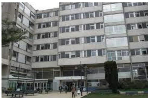
Bâtiment BMC hôpital de Pontoise
