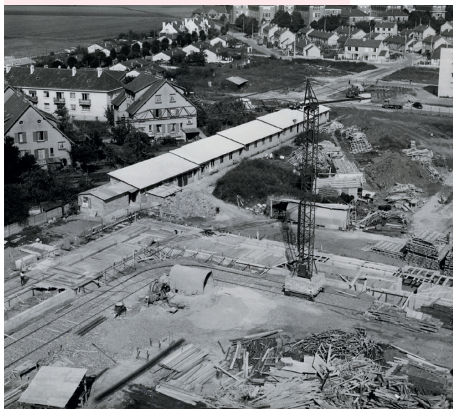
Chantier de construction aux Cordeliers, 1960-1970. Photothèque ARPE - Conseil départemental du Val d'Oise © Coll. part /D.R.
