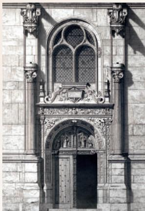
**Pilastre** : support vertical plat, engagé dans un mur ou une pile. Le pilastre fait référence aux constructions antiques, et comporte souvent un chapiteau.
