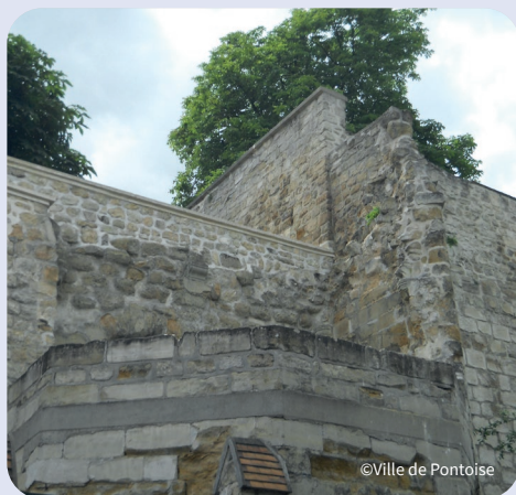
La tour du Pas d'Âne boulevard Jean Jaurès est un vestige des remparts du XIII e siècle.
