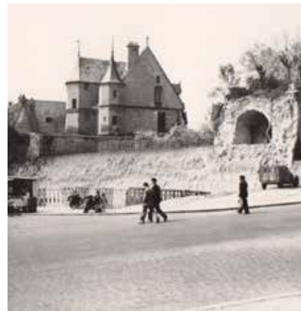
Marcel Kirschhoffer, Construction de la Poste rue Victor-Hugo, 1954.
